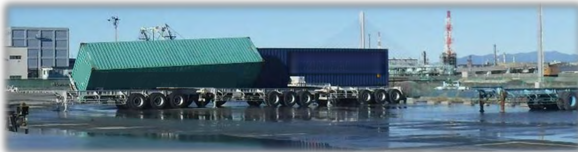
横浜港、台風後の南本牧ふ頭の様子
